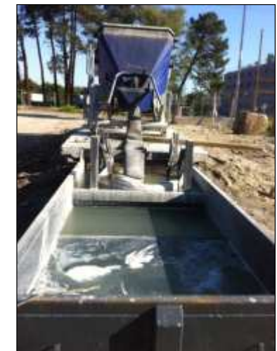
Benne de décantation pour le béton
